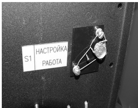
Рисунок Г.2 Пломбировка блока управления
